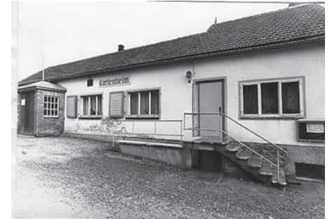
EB Gartenheim mit Küchenanbau um 1965
